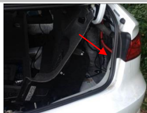
3.3 拆开原车右装饰件，ECU、蜂鸣器、负极各零部件安装在内壁钣金用 3M 胶固定好，防止松动；
